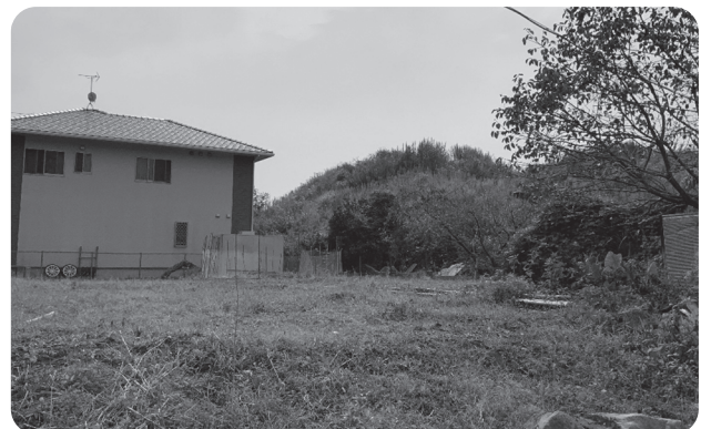
▲沼津市内の不適切盛土現場
