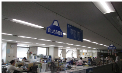
庁舎執務室のLED化
