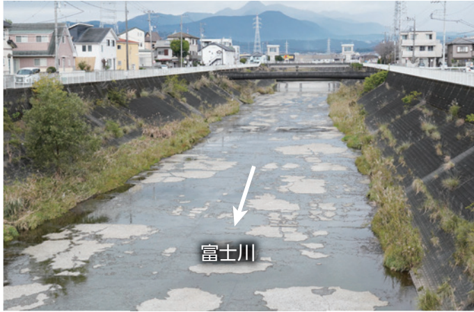
▲下流側から臨む星山放水路
