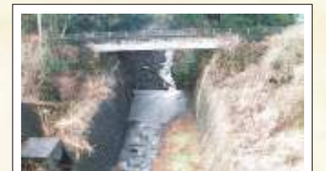
北山用水掛樋 大久保沢の深い谷の両側から、木製の樋を掛けて用水を通したとされる。
