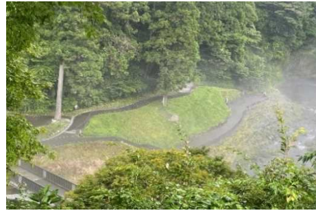
右岸下部整備後
