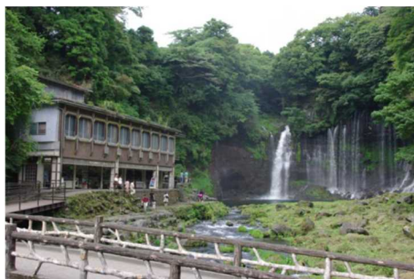
右岸下部整備前
