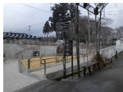
誘導板整備後
