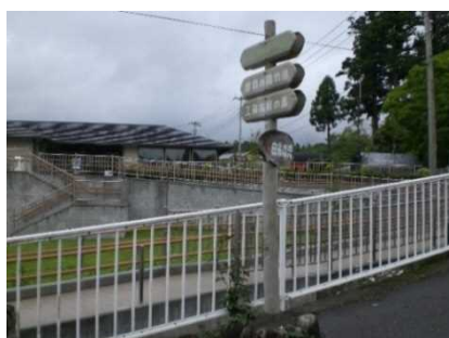
誘導板整備前
