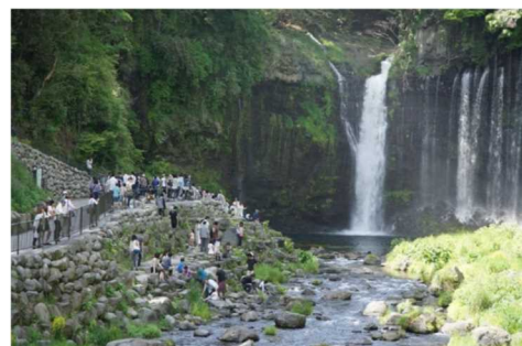
右岸下部整備後
