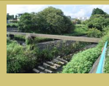
⑦ 弓沢川掛樋
