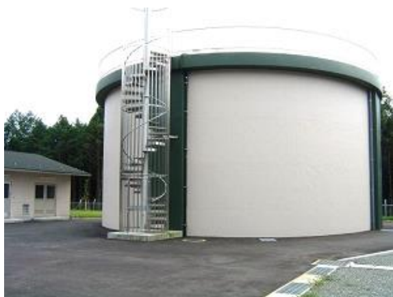
上井出第1配水池
